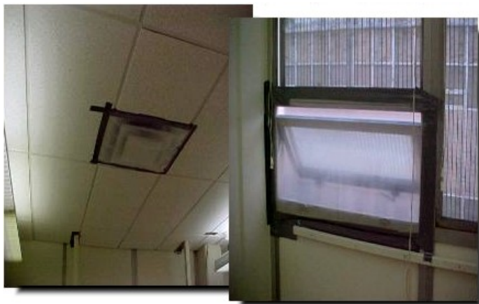
Figura 58 - Sigillare le eventuali aperture interferenti con l'area di bonifica
