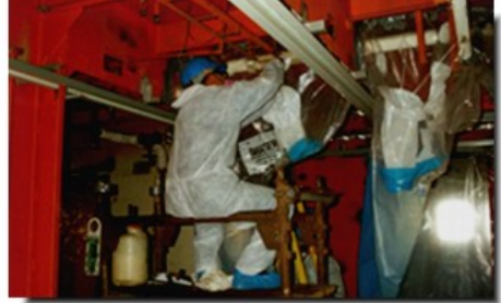
Figura 53 - Posizionamento del Glove-Bag
