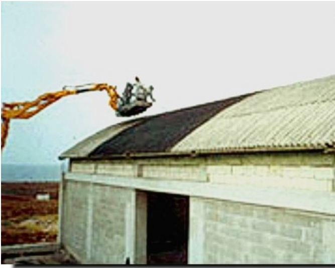
Figura 61 - Posa della sovracopertura
