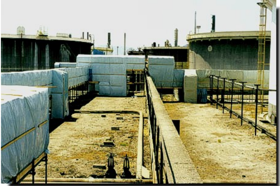
Figura 63 - Predisposizione area di cantiere
