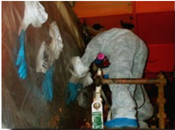
Figura 54 - Rimozione del materiale contaminato
