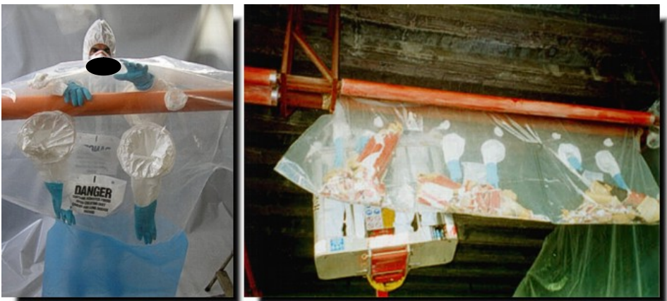
Figura 49 - Tecnica del Glove-Bag
