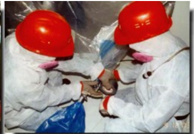
Figura 56 - Sigillatura del sacco con nastro
