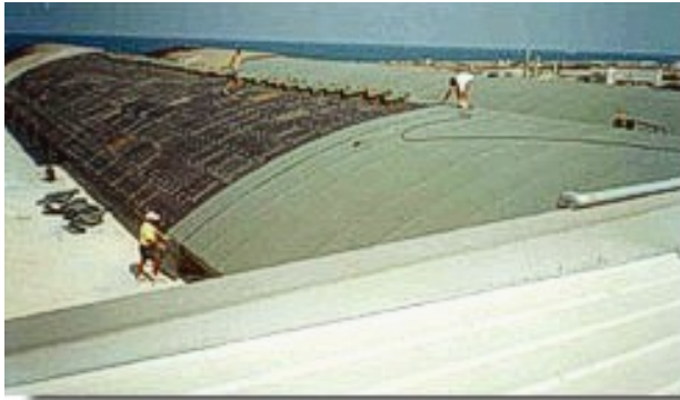
Figura 17 - Rivestimento di una copertura
