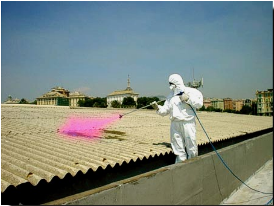
Figura 60 - Bagnatura del cemento-amianto
