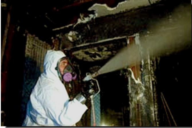
Figura 25 - Impregnante per evitare la dispersione di fibre d'amianto
