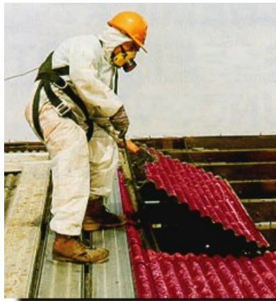
Figura 15 – Rimozione lastre in eternit
