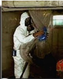
Figura 55 - Torsione del sacco
