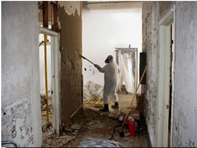
Figura 26 - Rimozione rivestimento dopo il trattamento
