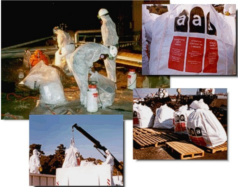
Figura 48 - Confezionamento, etichettatura ed allontanamento dei rifiuti
