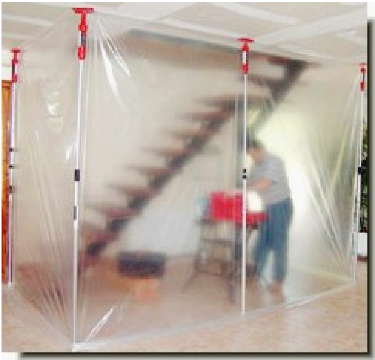
Figura 41 - Barriere in polietilene
