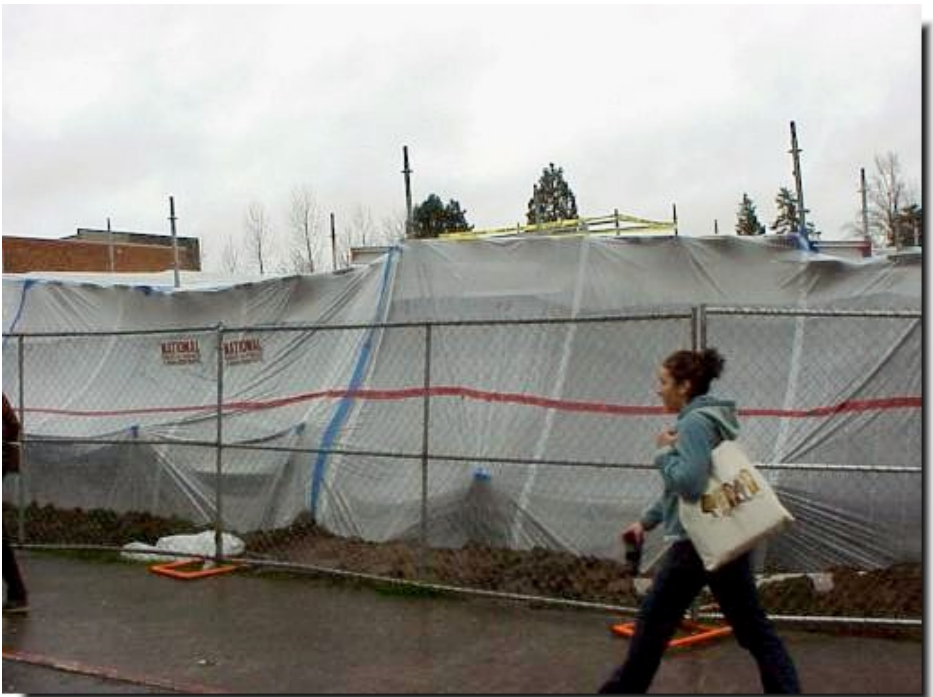
Figura 19 - Cantiere di lavoro
