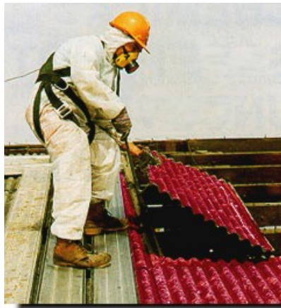
Figura 15 – Rimozione lastre in eternit
