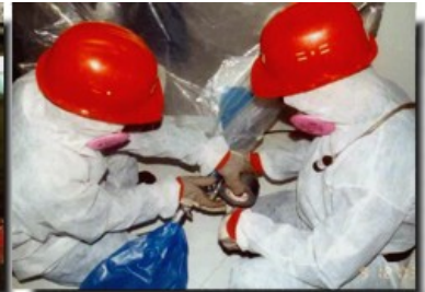
Figura 56 - Sigillatura del sacco con nastro
