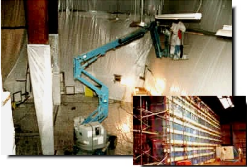
Figura 57 - Installazione delle opere provvisori
