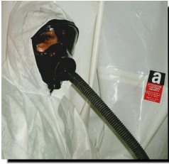
Figura 38 Maschera intera con respiratore
