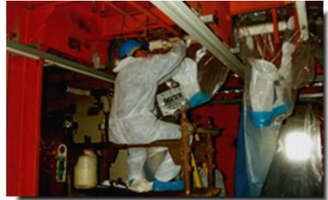
Figura 53 - Posizionamento del Glove-Bag
