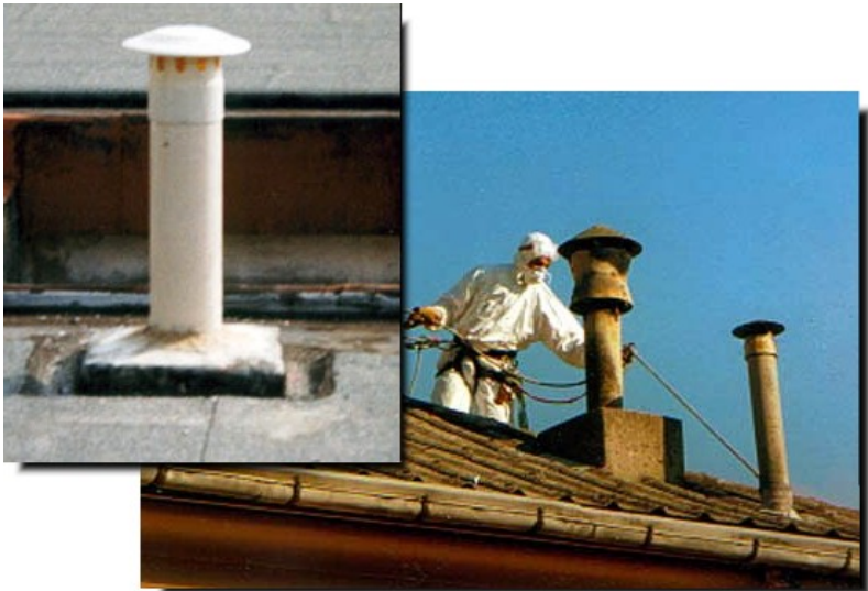
Figura 42 - Manutenzione di canna fumaria
