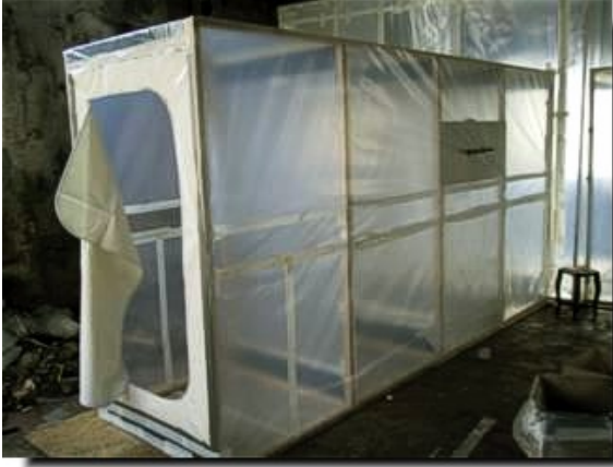
Figura 24 - Decontaminazione dei rifiuti e/o attrezzature
