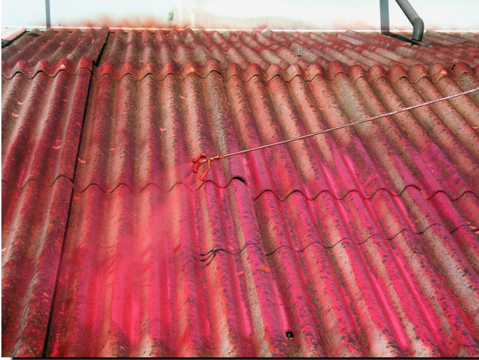
Figura 29 - Impregnante per evitare la dispersione di fibre d'amianto
