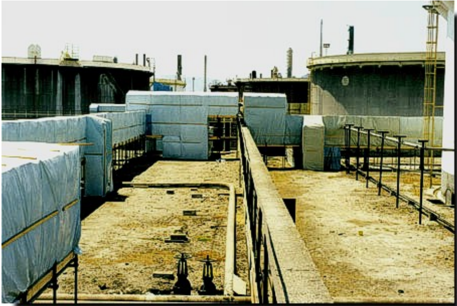
Figura 63 - Predisposizione area di cantiere
