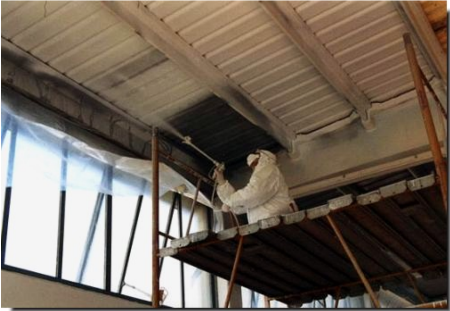
Figura 62 - incapsulamento
