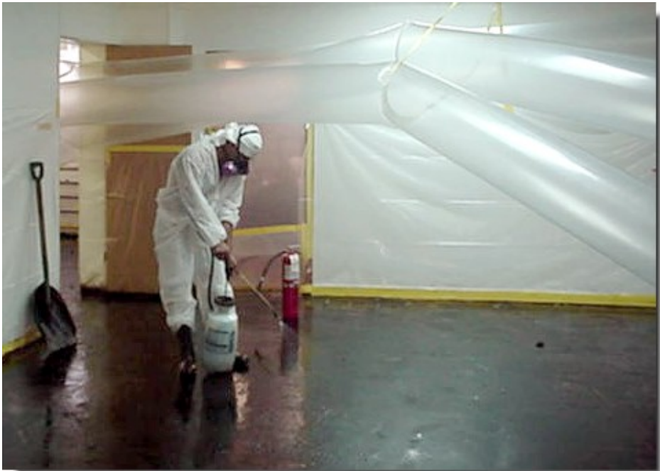
Figura 20 - Confinamento statico e dinamico
