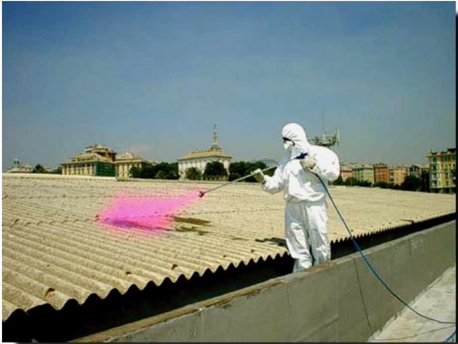
Figura 60 - Bagnatura del cemento-amianto
