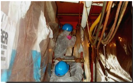
Figura 50 - Installazione opere provvisorie
