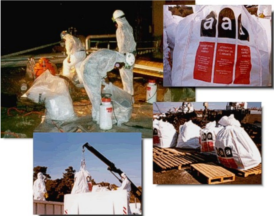
Figura 48 - Confezionamento, etichettatura ed allontanamento dei rifiuti
