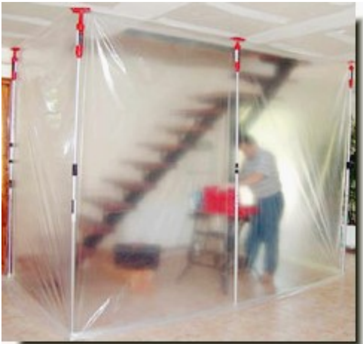
Figura 41 - Barriere in polietilene
