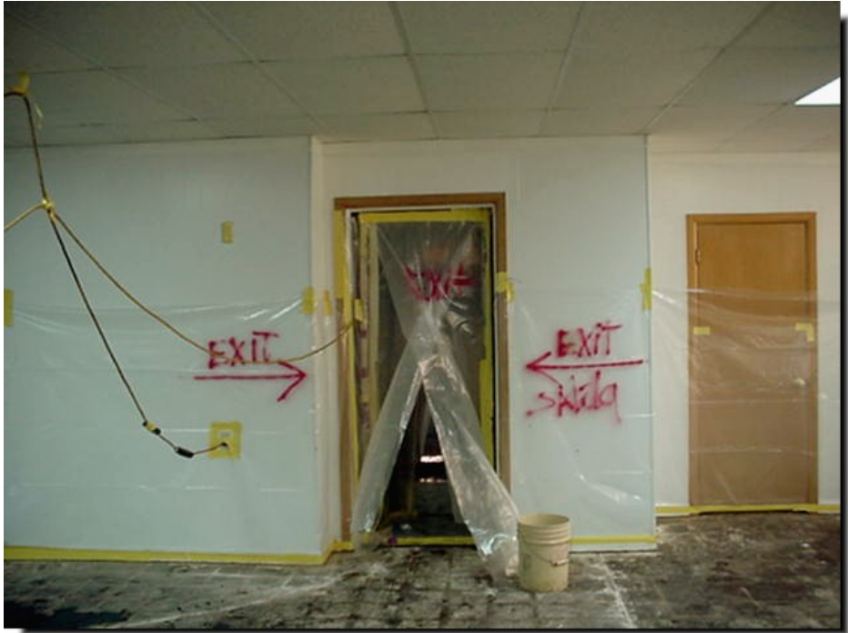
Figura 28 - Delimitazione dell'area di lavoro: uscita
