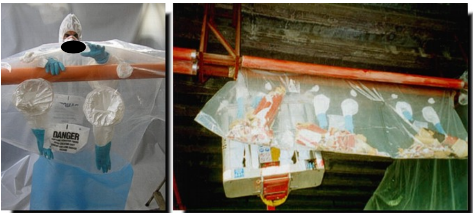
Figura 49 - Tecnica del Glove-Bag
