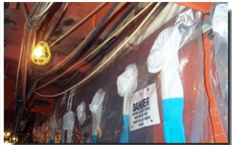
Figura 51 - Isolamento della zona con Glove-Bag
