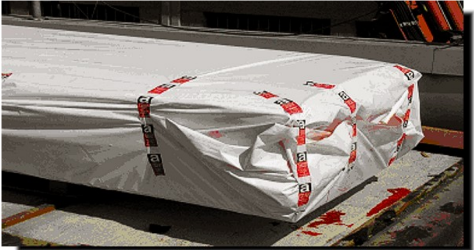
Figura 31 - Confezionamento ed etichettatura per lo smaltimento
