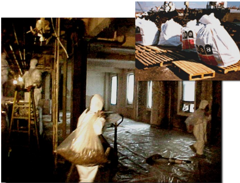
Figura 27 - Confezionamento ed etichettatura per lo smaltimento
