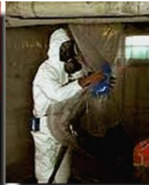
Figura 55 - Torsione del sacco
