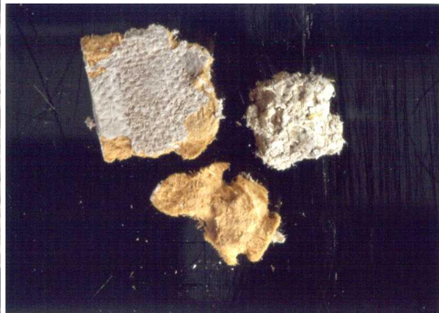
Frammenti di controsoffitto
