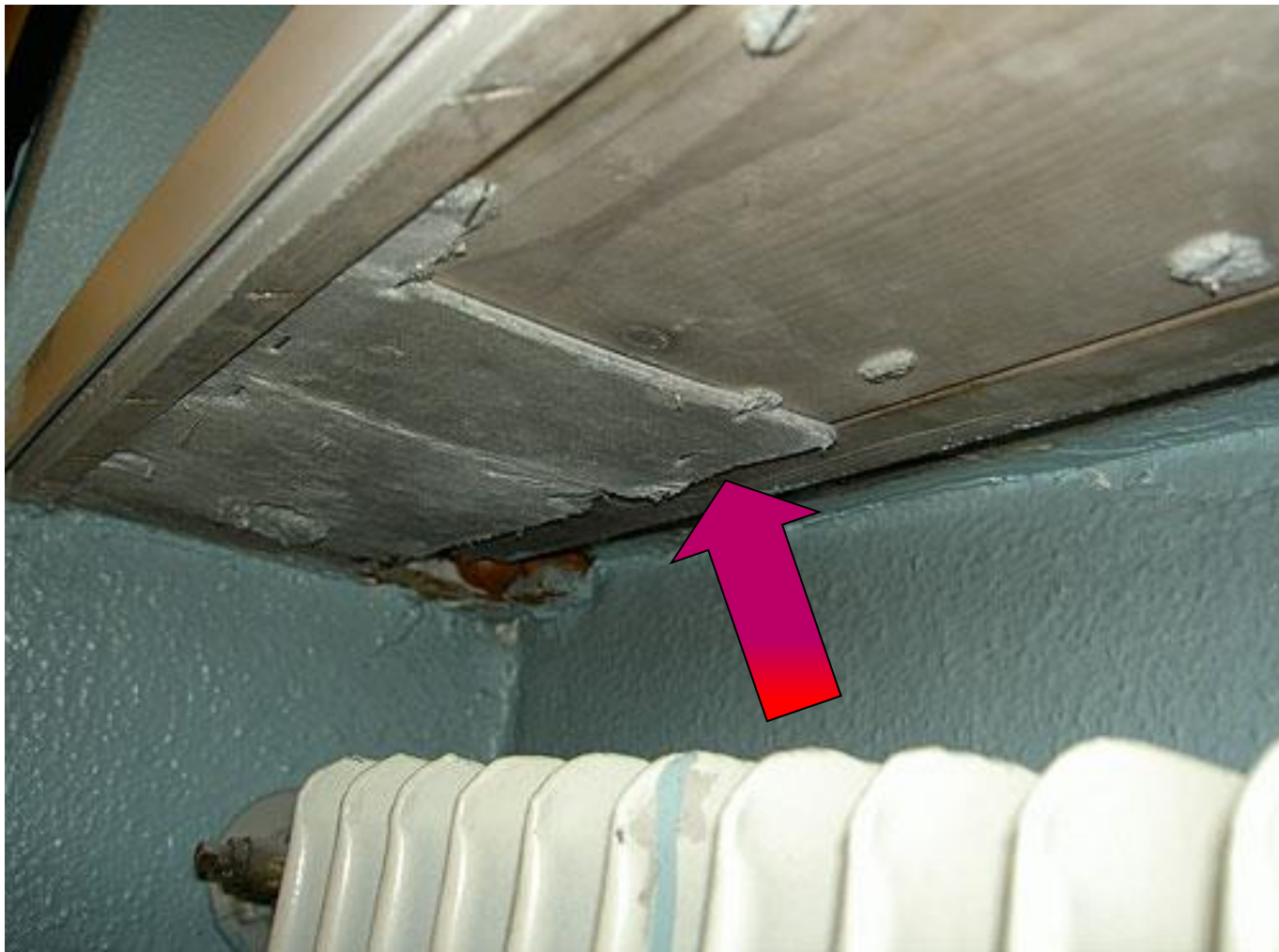
Cartone sotto mensola in legno sopra ad un termosifone
