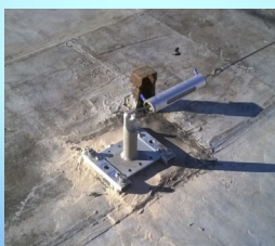
Esempi di dispositivi tipo C – UNI 11578
