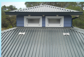
Esempi di dispositivi tipo A – UNI 11578
