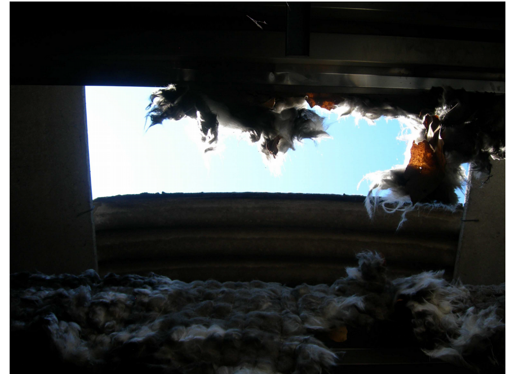
Sfondamento copertura in eternit
