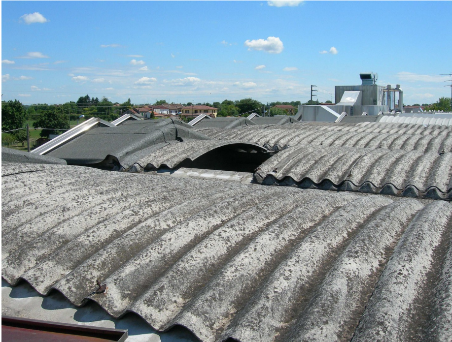
Sfondamento copertura in eternit
