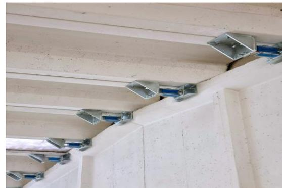
***Indicazioni per la realizzazione in sicurezza di interventi su edifici industriali a seguito degli eventi sismici***
