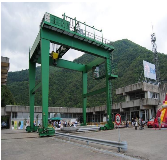
Piazzale esterno della centrale con in primo piano il carro ponte da 130 tonnellate. La centrale si sviluppa in verticale sotto il piazzale
