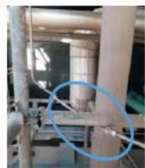
Figura 1 Interferenza per errato posizionamento del ponteggio - deformazione tubo strumentazione (cortesia Iplm)
