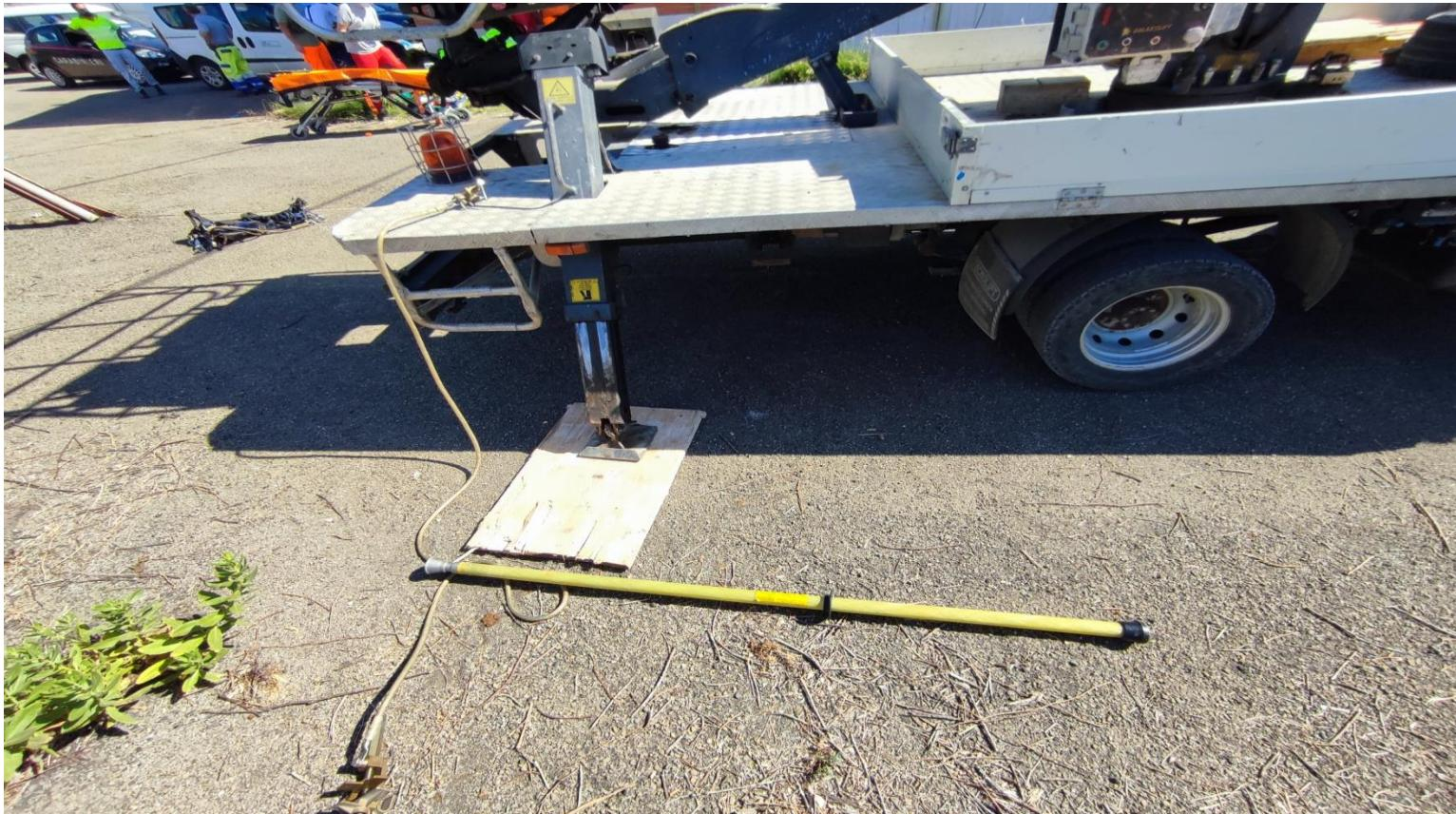
Dispositivo di corto circuito al quale è collegato anche un fioretto dielettrico, ovvero l'asta che viene utilizzata per mettere in opera il dispositivo di corto circuito .
