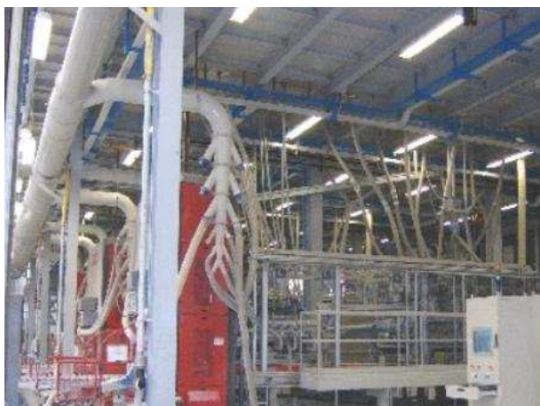
Tubazione principale e calate per l'aspirazione delle polveri aerodisperse delle presse,
