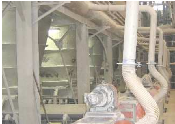
Tubazione con calate per l'aspirazione e raccolta delle polveri aerodisperse all'uscita dei silo.
