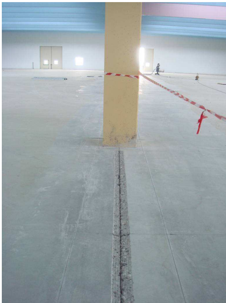
Figura 3.18. Vista dei giunti di dilatazione e di un giunto "di getto" della pavimentazione per edifici industriali
