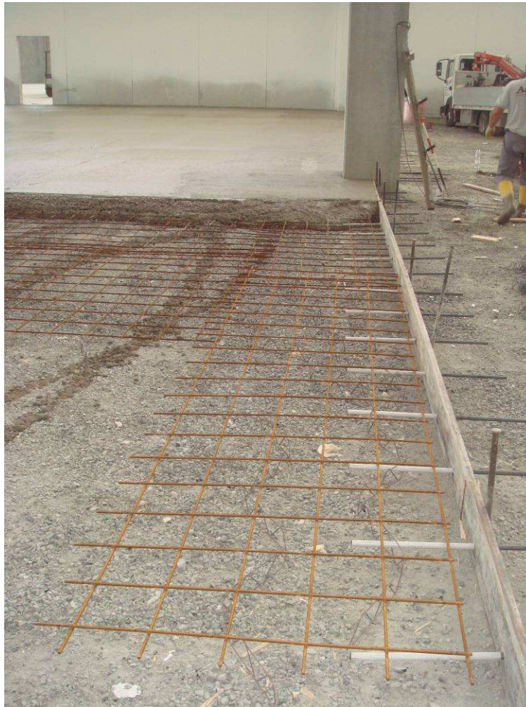
Figura 3.14. Posizionamento della rete elettrosaldata della pavimentazione per edifici industriali
