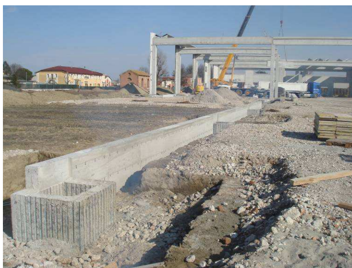
Figura 3.8. Fondazione gettata in opera per edifici industriali
