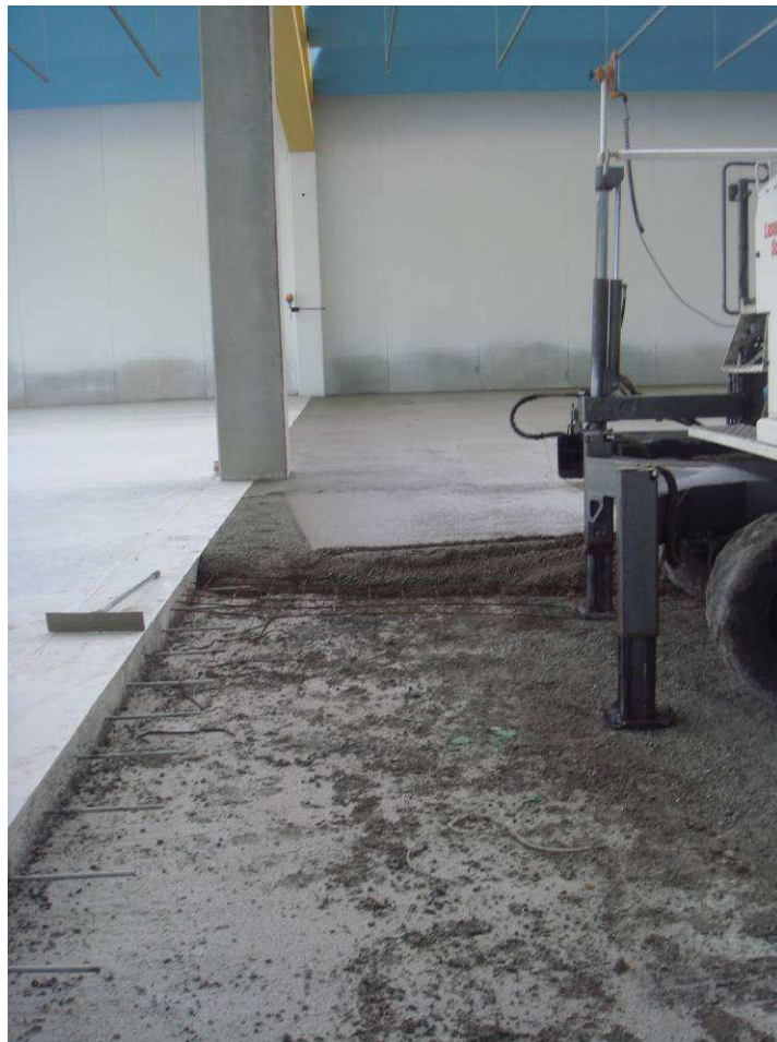
Figura 3.13. Fase di ripresa del getto della pavimentazione per edifici industriali
