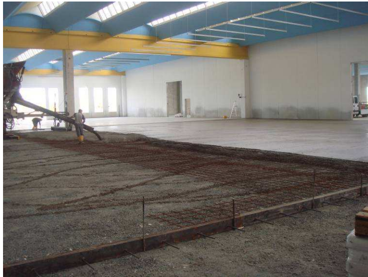
Figura 3.12. Fase di getto della pavimentazione per edifici industriali
